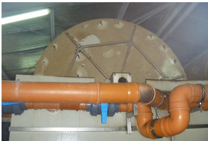
Figure 2.6 - Traitement biologique - disques biologiques
