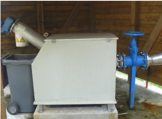
Figure 2.1 - Prétraitement : dégrilleur
